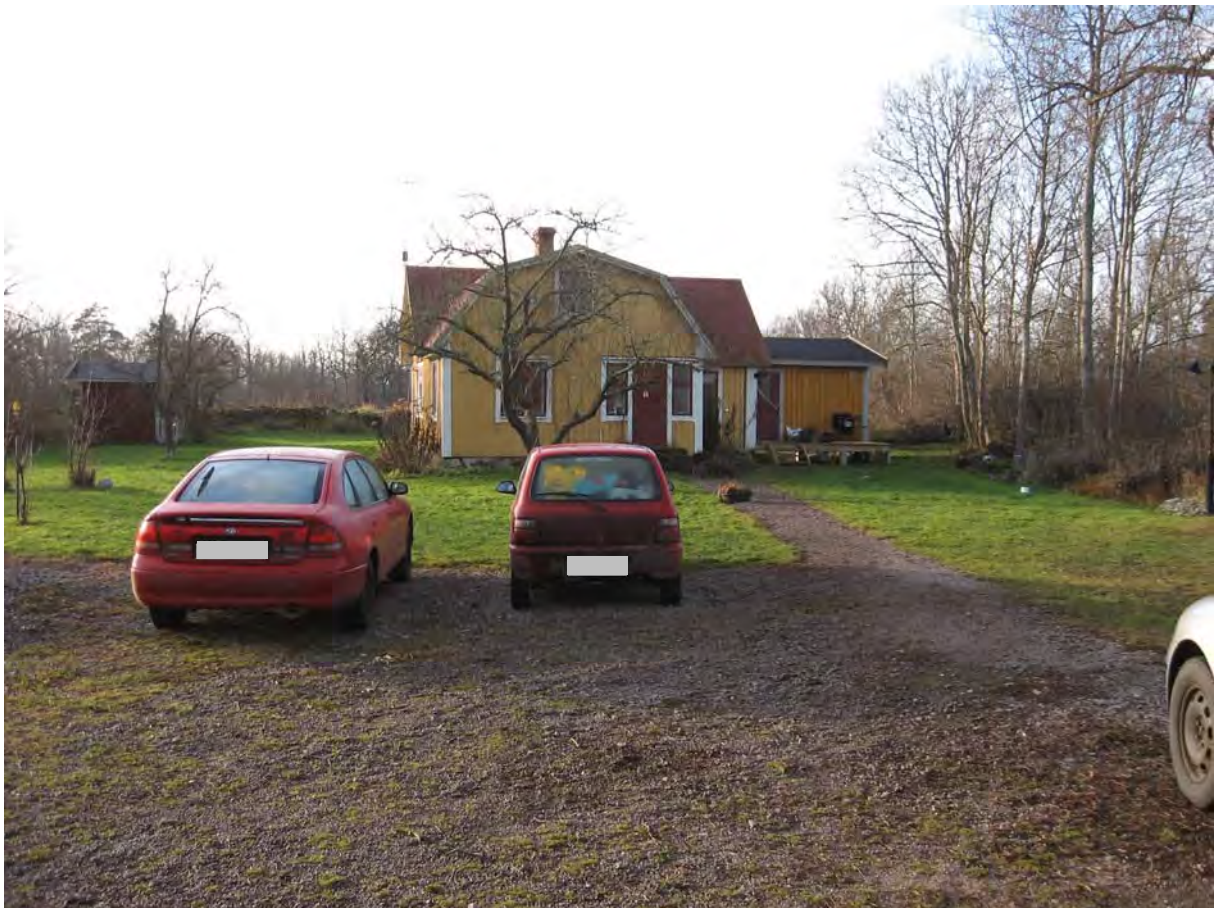
Bild 1. Brandbyggnaden där brandrummet ligger i den vänstra delen av bottenvåningen på byggnaden.
