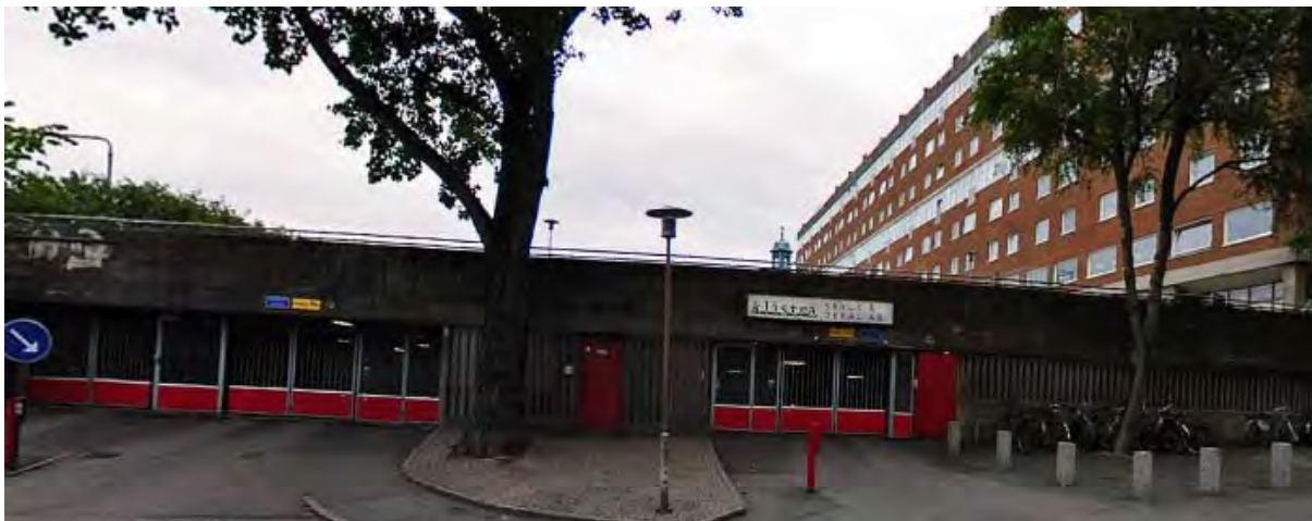
Bild 6. Portarna där Frölunda började insatsen från Betzensgatan. På fotot syns även flerbostadshusets placering i förhållande till garaget.
