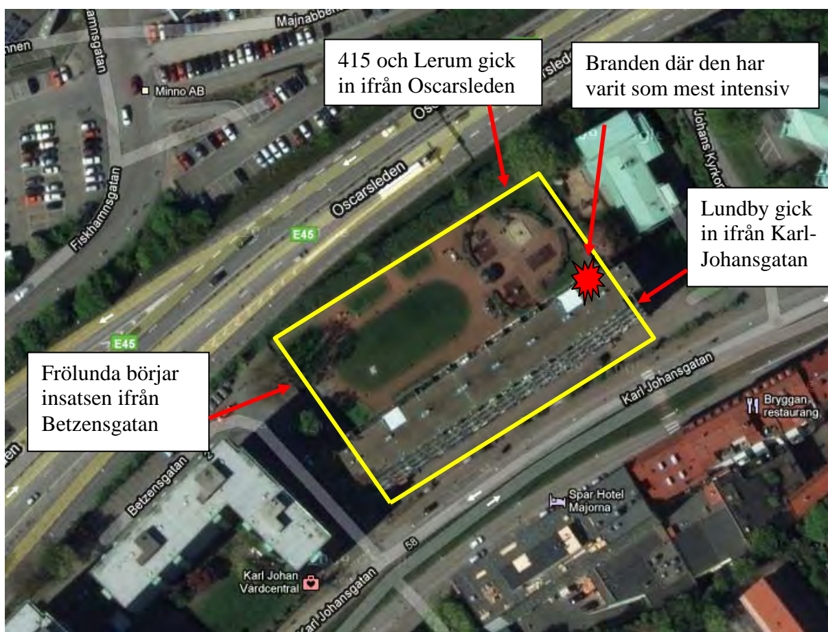
Bild 4. Flygfoto över flerbostadshuset och parkeringsgaraget. Den gula fyrkanten markerar gränserna för garaget.
