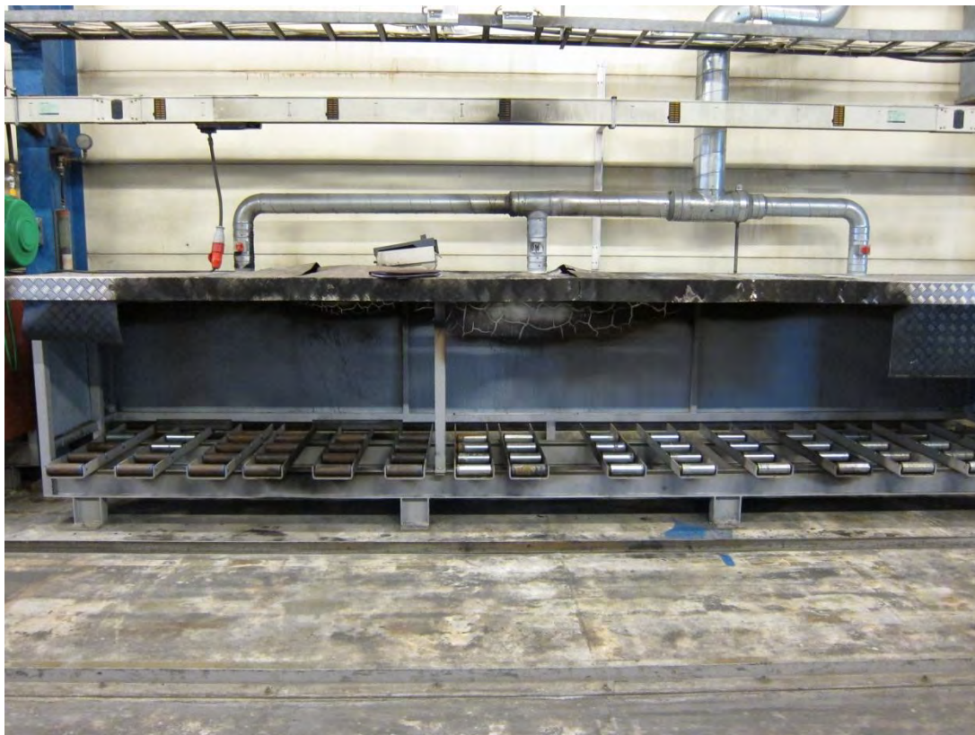
Batteristallaget. Utsug över varje batteri. Branden startat under utsuget i mitten
