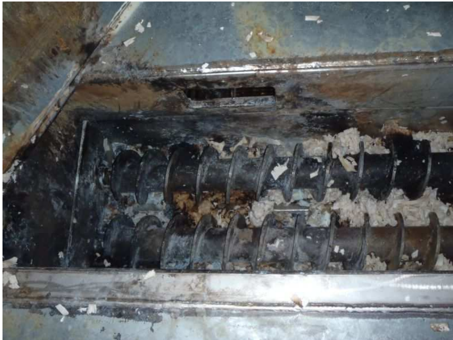
Bild 12. De två högra skruvarna som har brandbelastas.
