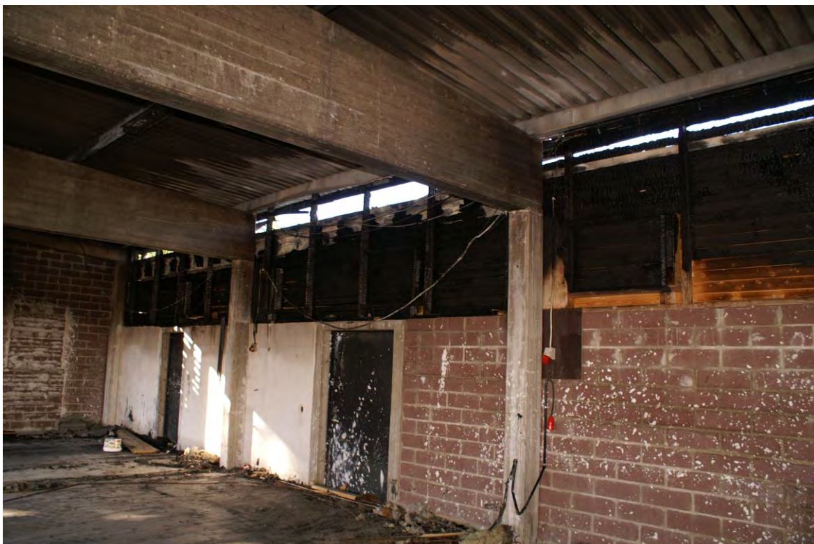
Väggen mot carporten
