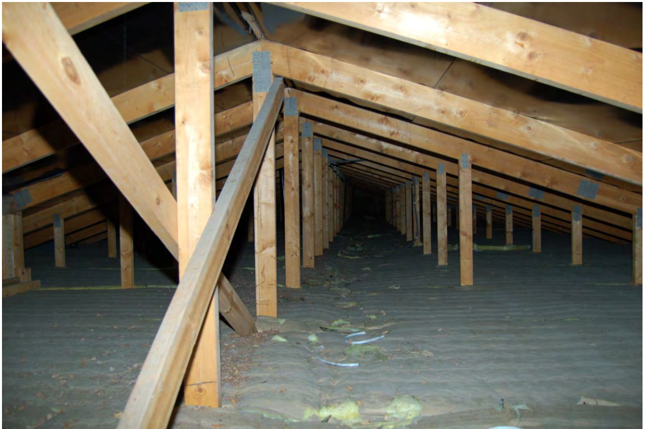
Bild 9. Bild från oskadad vind i likadan byggnad. Vinden saknar sektionering. Takstolar av trä sammanfogade med spikförband.
