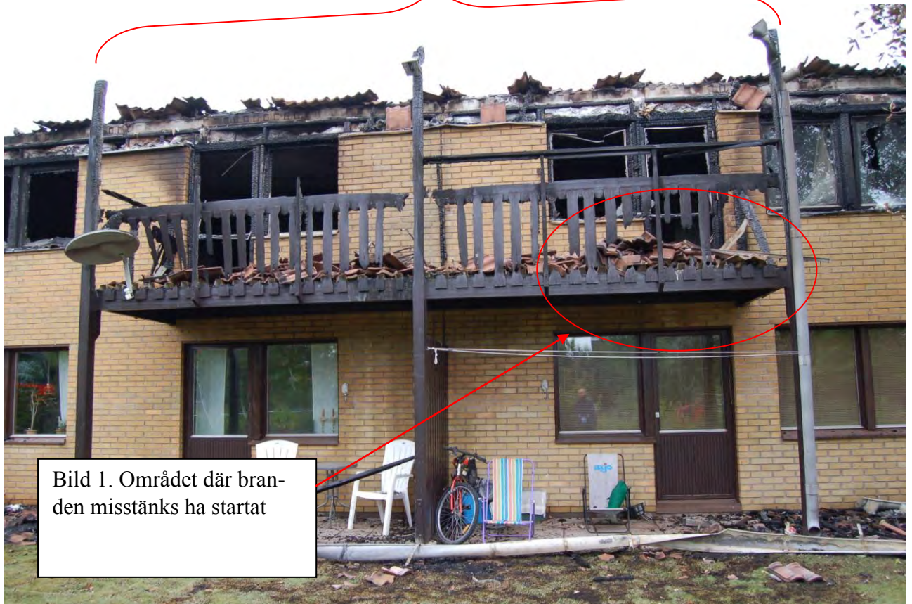
Bild 2. Taket utdraget över entréer och balkonger
