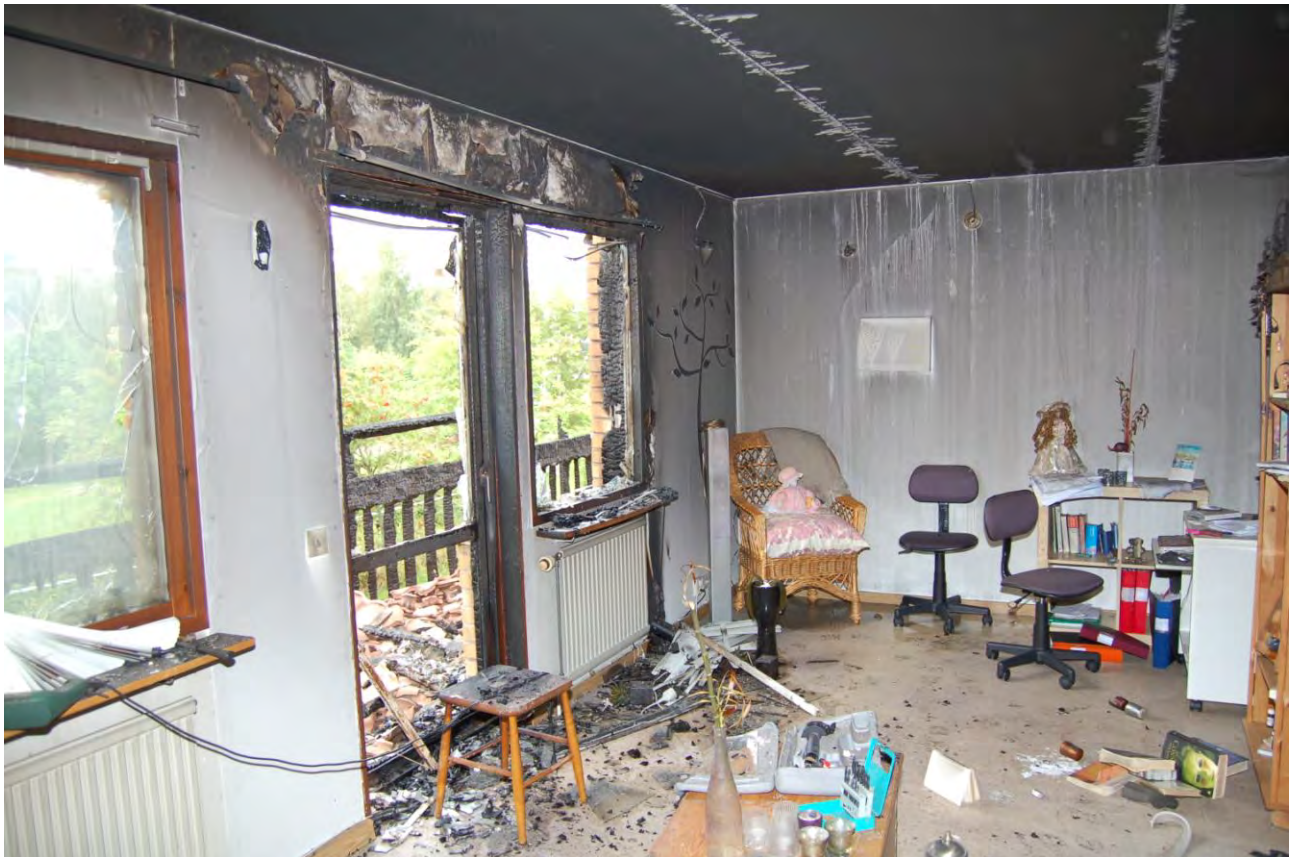
Bild 7. Lägenhet ■ A. Utifrån komna brandskador. Låg brandbelastning innanför de inrasade fönstren.
