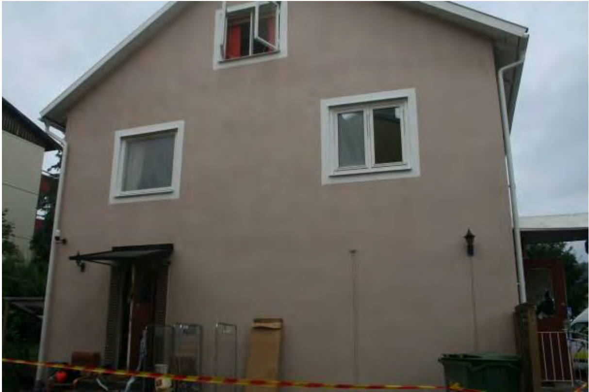
Bild 3. Gaveln med ingång till restaurangköket.
