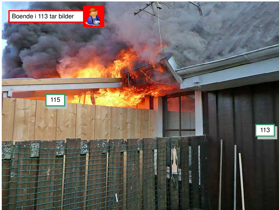
Fig. 2. Fotografi taget av boende i 113 under skede 1. Bilden visar att branden har spridit sig längs takfoten och är i gränsen mellan 115 och 113.
