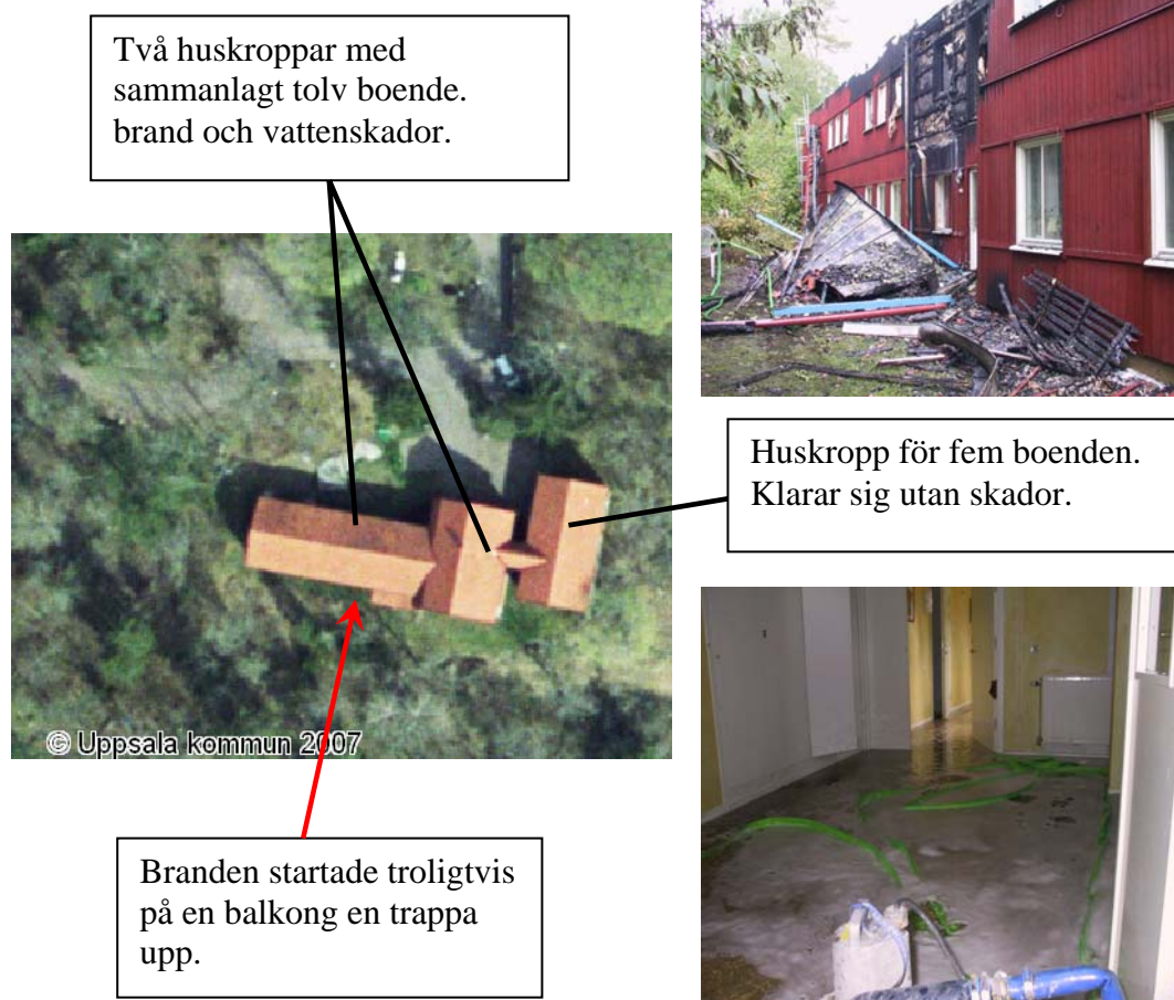
Bild 3 Flygfoto xxxxxxxxxxxxxxx samt skador på huset.
