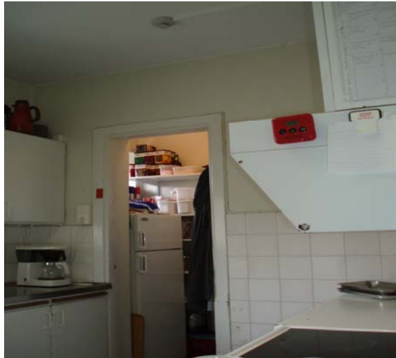
Kök med spis till höger och värmedetektor i tak
