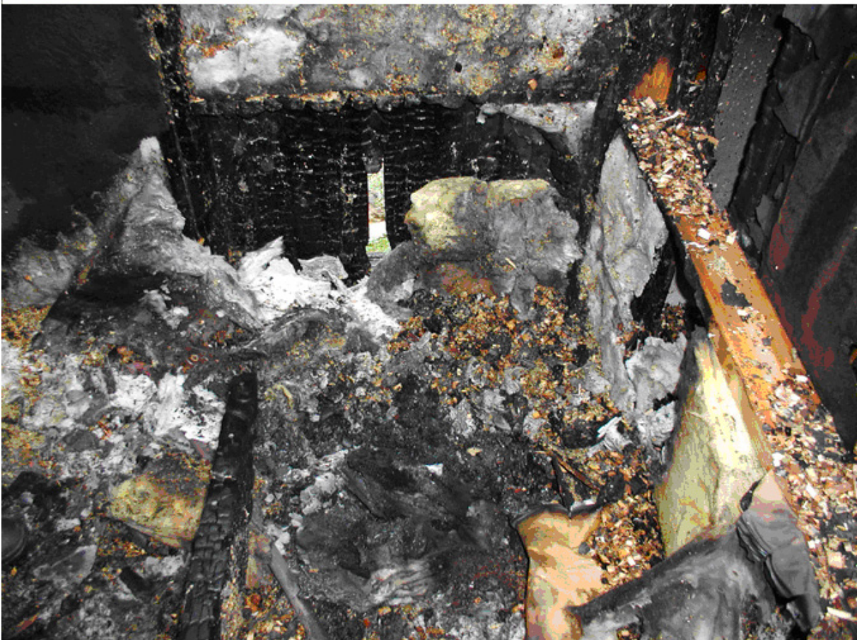
Bild 3 Primärbrand överst (brandhärd 1) och förmodad sekundärbrand (brandhärd 2) under.
