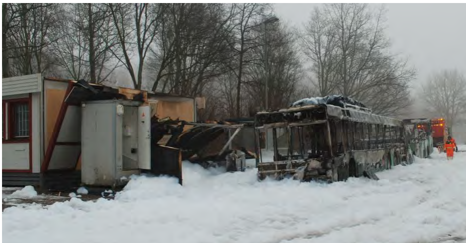
Bild 3. De två utbrända bussarna samt den intilliggande byggnaden som brandskadades.
