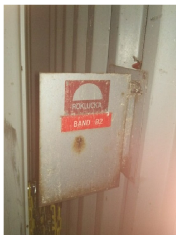
Bild 4. Öppningsanordning röklucka
