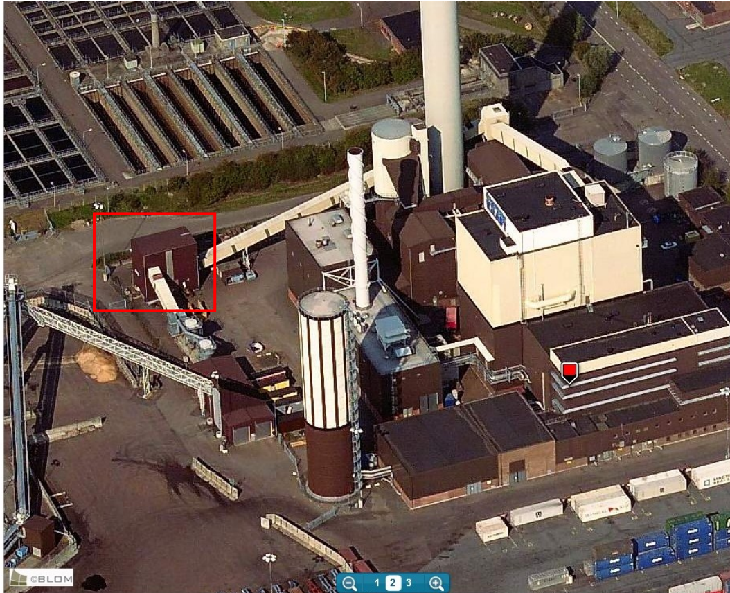
Bild 2. Brandskadad byggnad (omlastningsbyggnad) inom Västhamnsverket
