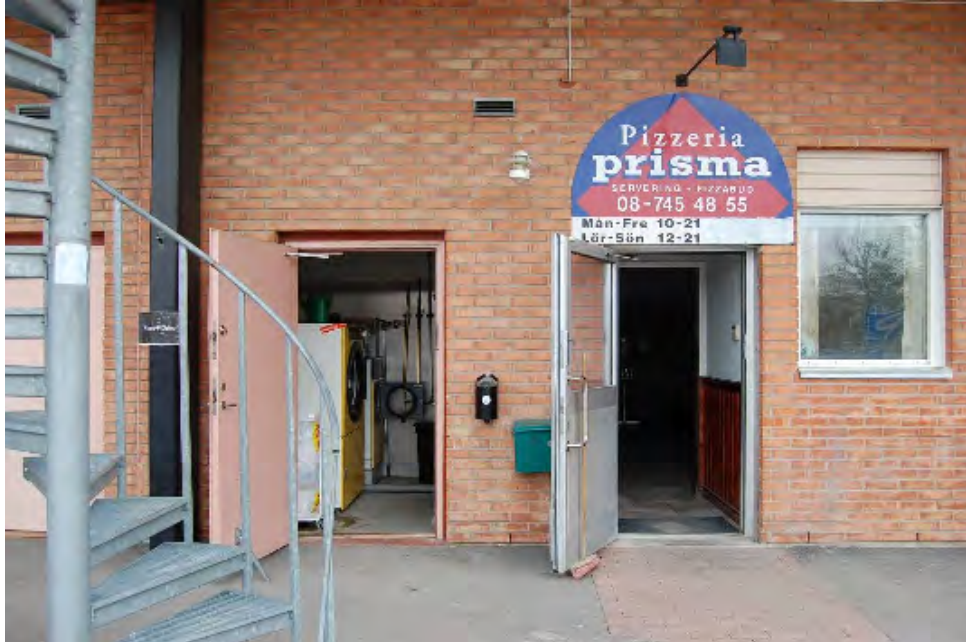
Bild 1. Entrén till utrymmet där det brunnit och pizzerian intill.
