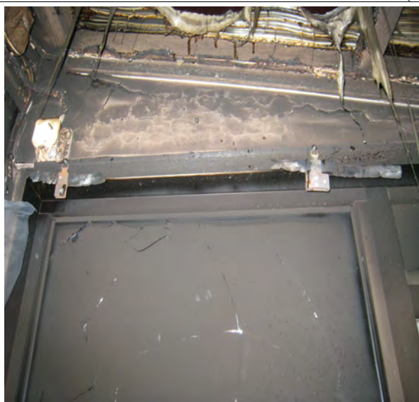
Väggtag vid takliv samt upphängning för gardin
