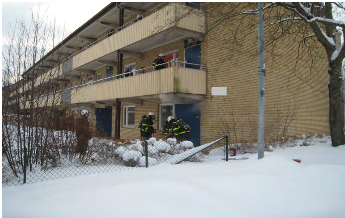
Entré sida vid inträngning i brandlägenhet.
