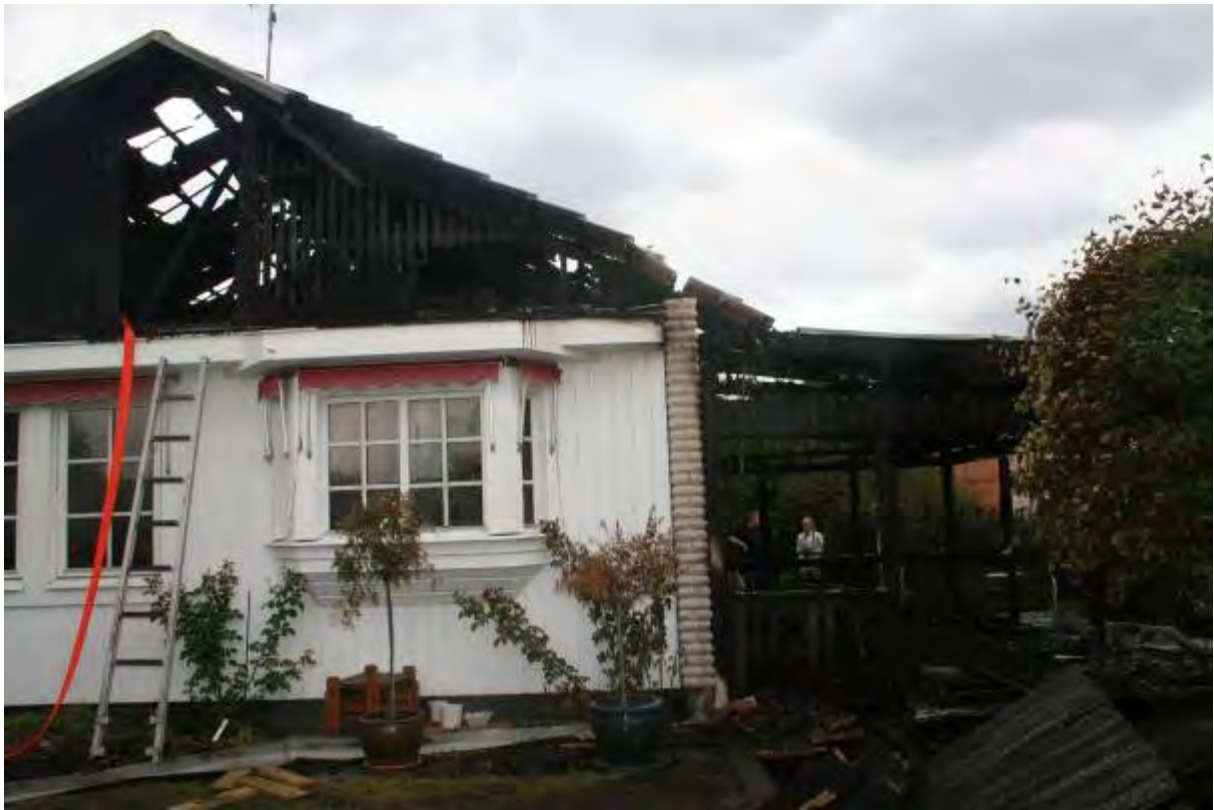
Bild 1. Byggnadens västra sida.
