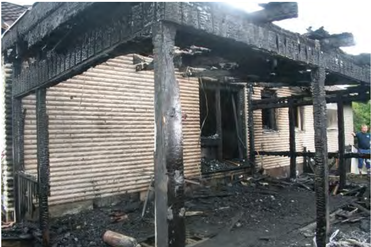
Bild 2. Byggnadens södra sida, notera brandsläckaren, grillen är skydd bakom hörnspelaren.
