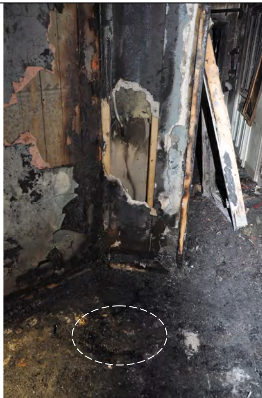
Bild 10. Trapphuset, till vänster om lägenhetsdörren. Cirkeln visar placeringen de djupa brandskadorna i trägolvet
