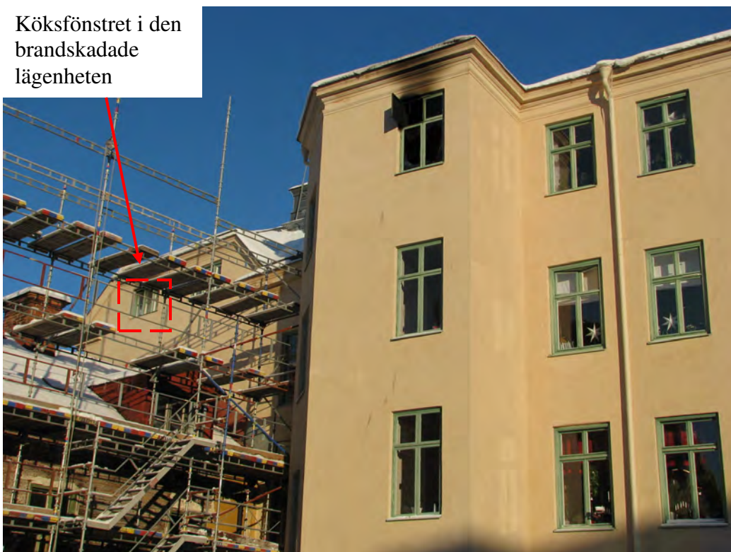
Bild 4. Trapphuset från innergården. Innanför det översta fönstret var primärbranden. Observera soten på fasaden ovanför.
