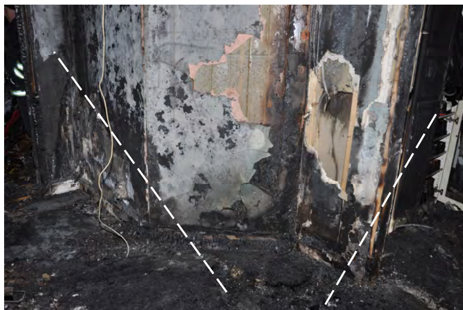
Bild 11. Primärbrandplatsen. Djupa brandskador, golvsockeln är bortbränd. Brandbilden visar ett brand-V, spetsen visar primärbrandområdet.
