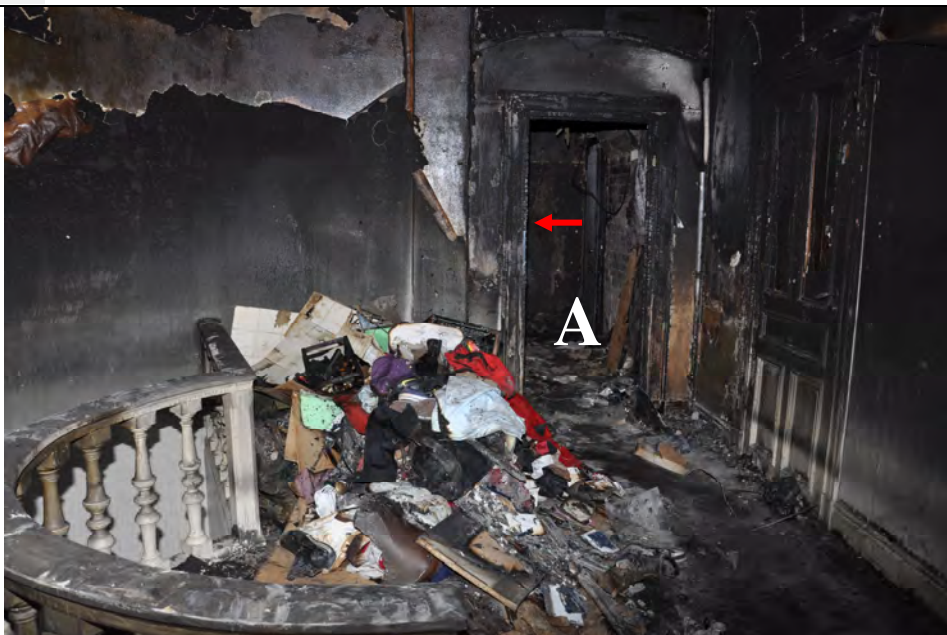
Bild 7. Trapphuset, högst upp. A – primärbrandområde. Den brandskadade lägenheten är till vänster bakom väggen, röd pil. Högen med kläder och annat som syns på bilden har brandpersonalen placerat där.
