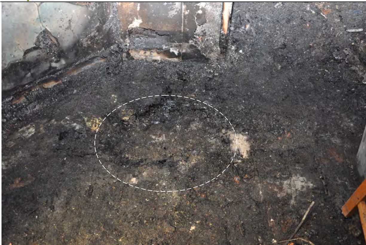
Bild 12. Djupa förbränningar i golvet inom ett markerat område. Arean ca. 50x50 cm, djup ca. 8 cm.
