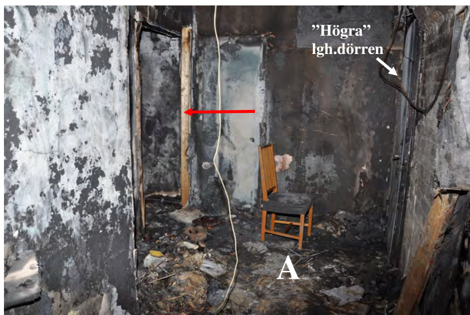
Bild 8. Ytskiktet på väggar och tak var enkel gips monterad på pärlspont. På golvet till vänster om dörren i trapphuset stod enligt uppgift förvaringsskåp för kläder och skor. När rökdykarna bröt upp dörren till lägenheten lossnade den från karmen.
