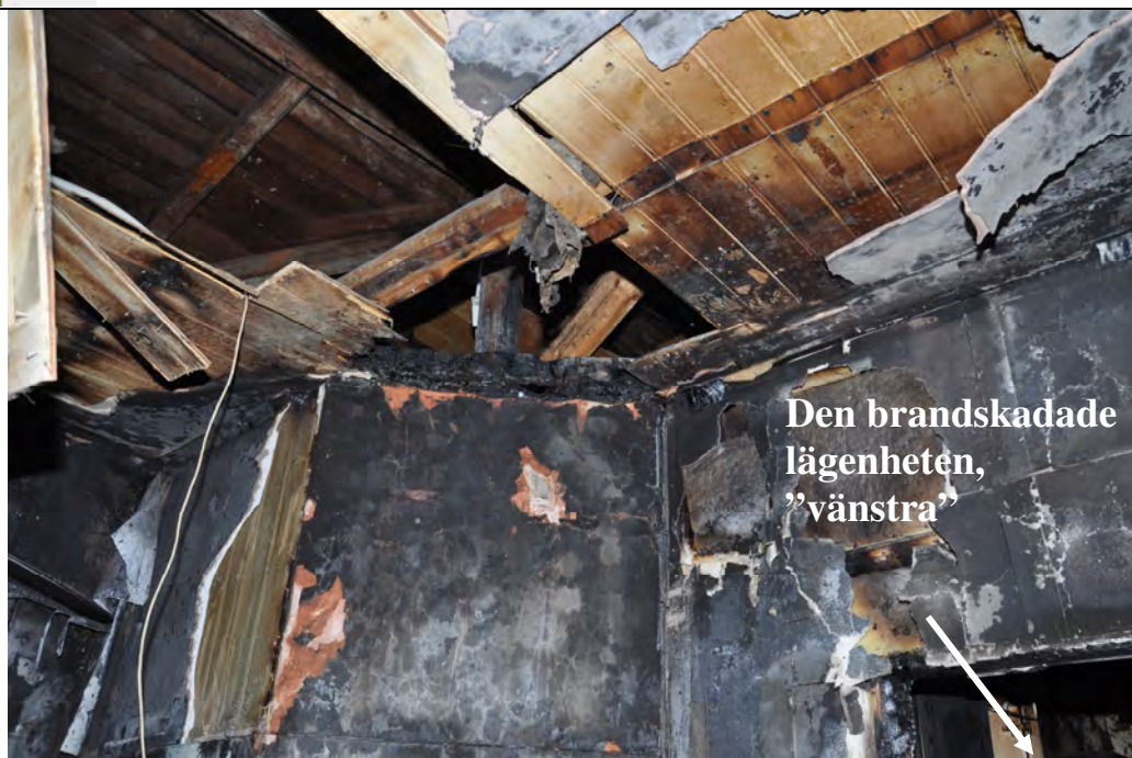
Bild 14. Brandpersonalen har sågat upp innertaket för att säkerställa att branden inte spridit sig till vinden. Att branden inte spridit sig beror med största sannolikhet på att gipsskivan fördröjt brandspridningen och att brandpersonalen angrep branden innan den bröt igenom innertaket.
