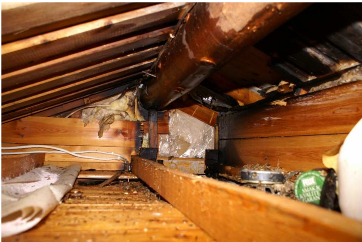
Bild tagen ovan undertaket, mellan brädorna i överkant på bilden och yttertaket ligger isolering.
