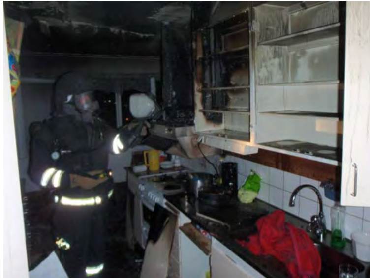
Bild 2. Skåp och fläkt kontrolleras med hjälp av värmekamera.
