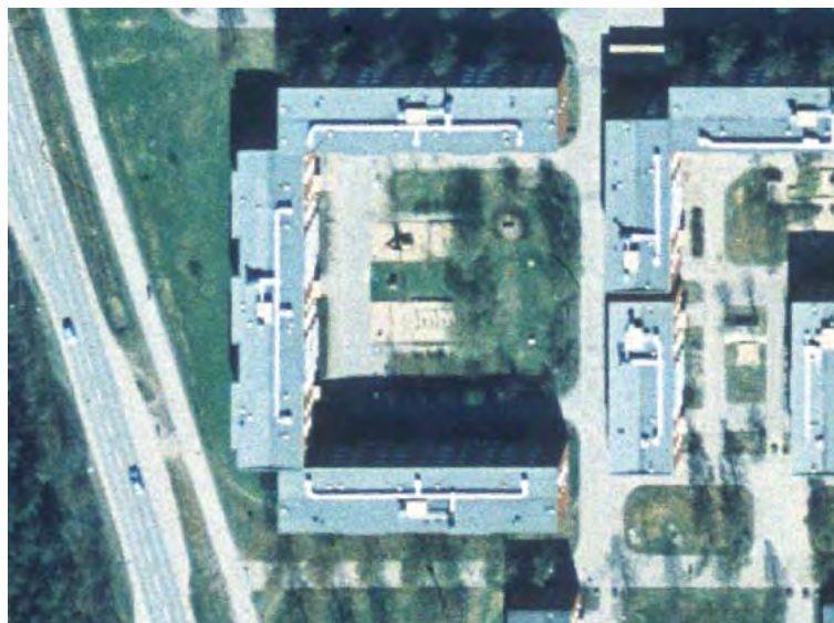
Bild 1. Orthofoto över byggnaden på Geografigränd. Branden startade i huskroppen som ligger längst ned i bilden.
