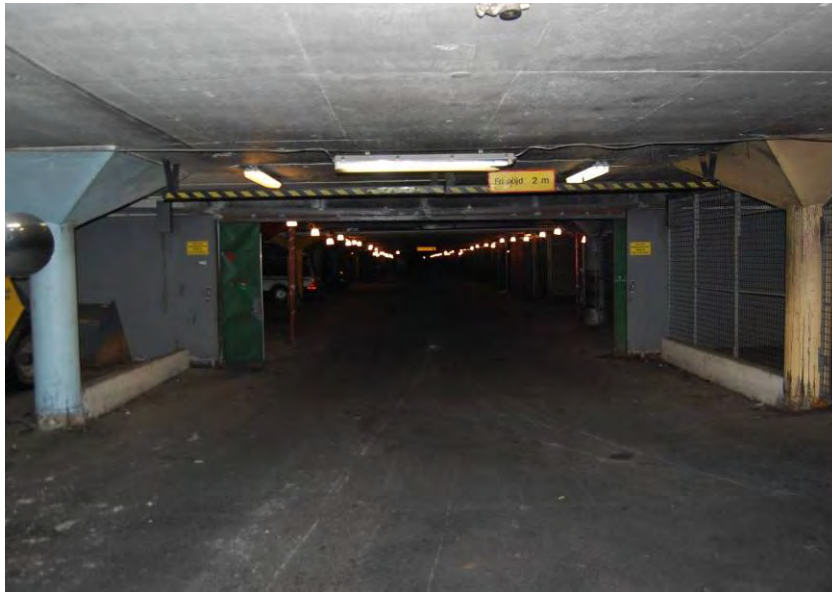
Bild 4. Stålporten som delar av norra och södra delen av garaget.
