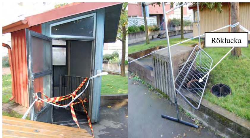
Bild 10. Trapphus från innergård ner till garage samt röklucka från garage.
