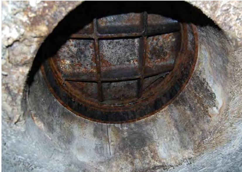
Bild 11. Röklucka sedd nerifrån garaget
