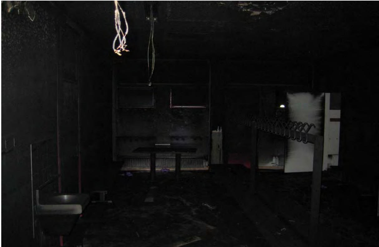
Omklädnadsrummet intill svårt sotskadat, har varit en brand i rökgasskiktet
