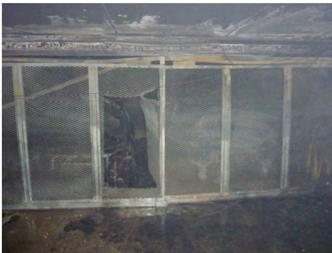
Bild 6. Här syns metallburen som de två bilarna som brann var parkerade i. Bilden visar även hålet som rökdykarna tog upp med kapen för att komma åt att släcka effektivare.
