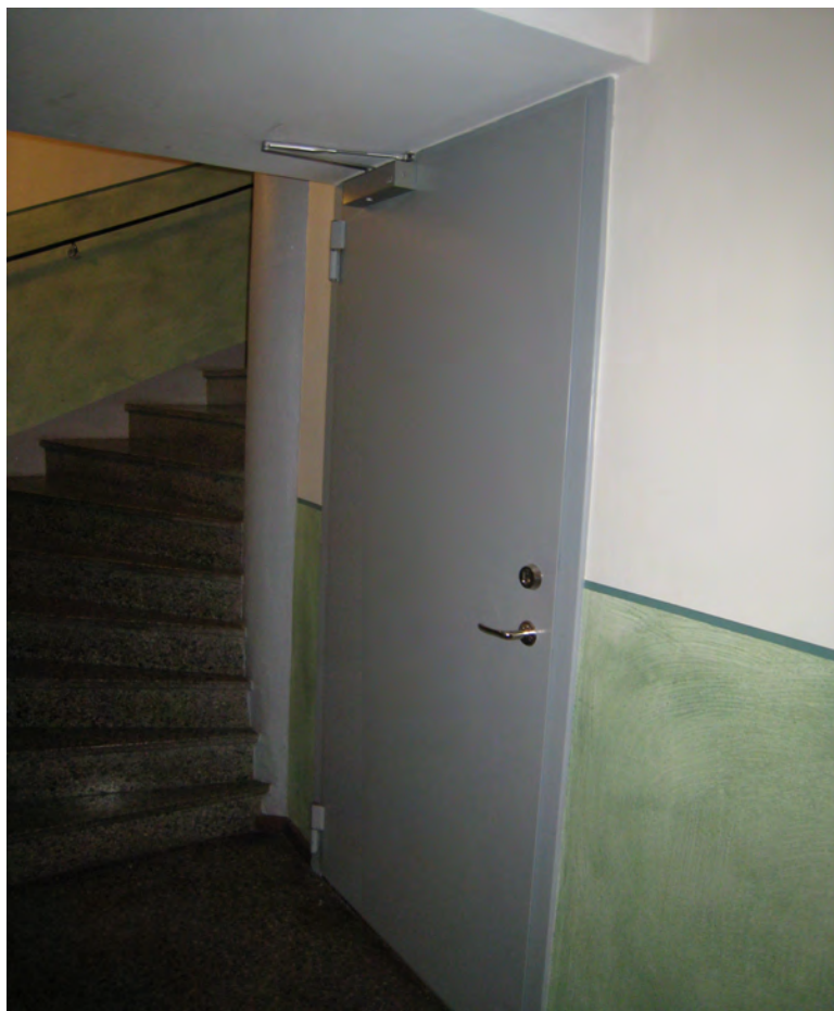
Dörr mot gång från trapphus. Bakom denna sitter ytterligare dörr mot gammalt soprum.
