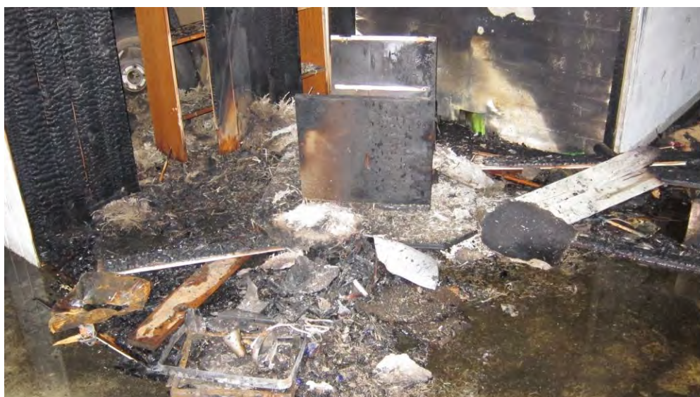
Källarförrådet var uppskattningsvis 2-3 m 2 .
