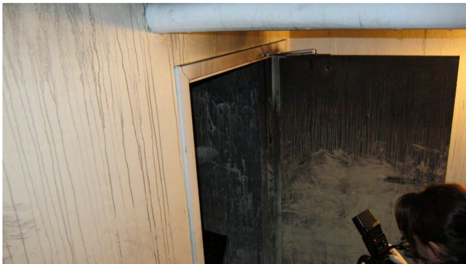
Dörren mellan trapphuset och källaren.
