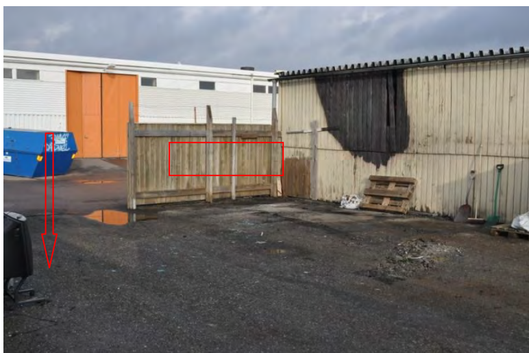
Planket bakom bilen med aluminiumsplitter i. Vid pilen hittades splitter från sidorutorna
