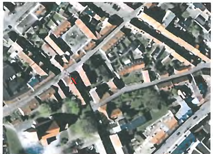
Foto 5 Översiktsfoto där rött kryss markerar huset som brann.
