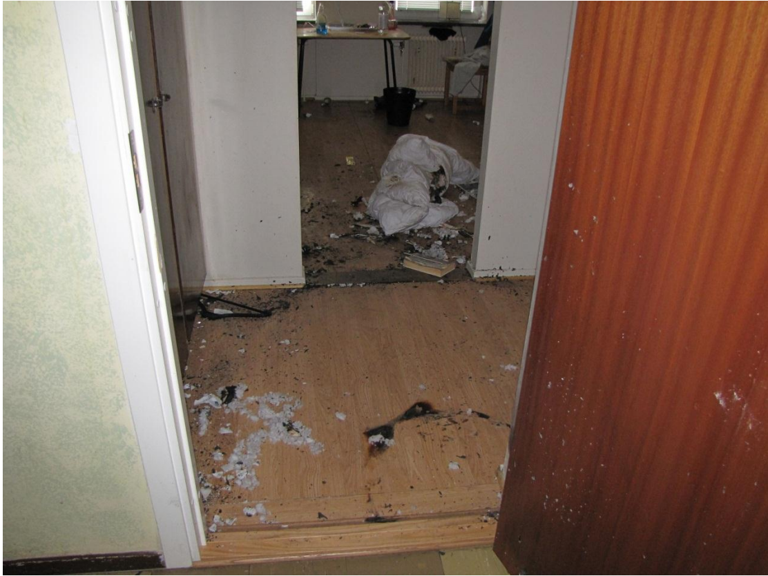
Bild 1. Brandskador i golvet innanför dörr samt brandskadat täcke
