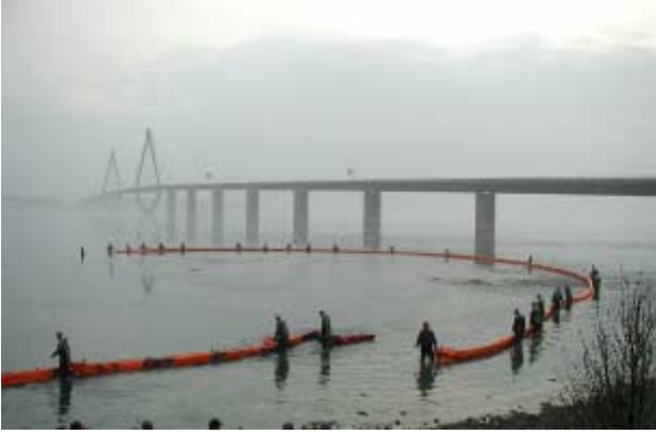
Billede Fejl! Ukendt argument for parameter.. Udlægning af flydespærring ved Farøbroen.
