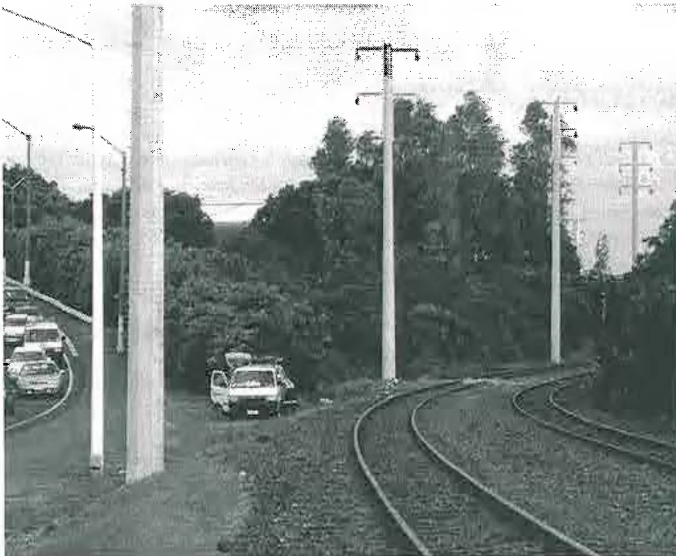
Foto 3. Den provisoriska ledningsgatan förlades utmed järnvägen på en 8,5 km lång sträcka. Kostnaden uppgick till 25 Mkr. FOTO: MATS KERO
