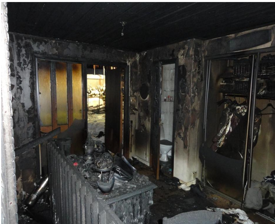
Trappan och dörr ut.
