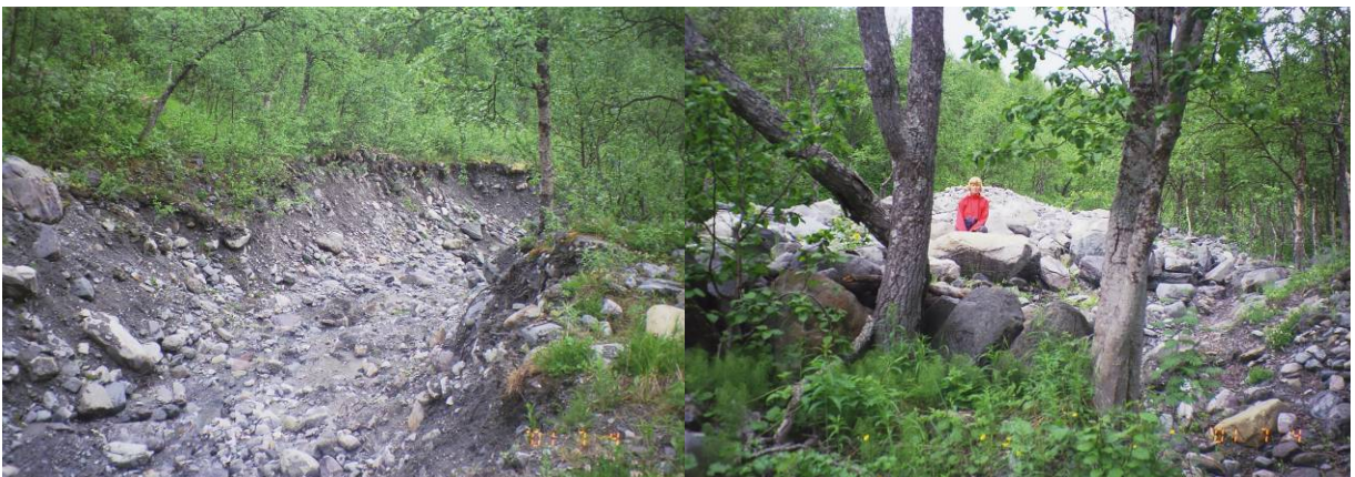
Figur 1.3. Spår efter slamströmmar i Kittelfjäll. Till vänster en erosionskanal och till höger en slamströmskon (foto J. Fallsvik).
