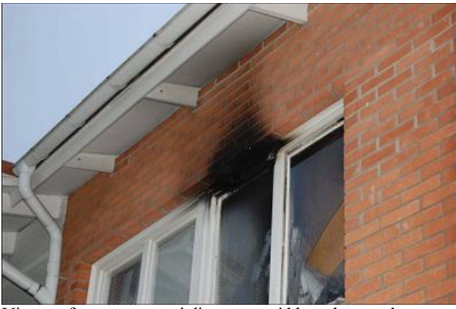
Visar ett fönster som varit lite öppet, vid branden, med brand och sotskador som följd. Notera att takfoten är tät.
