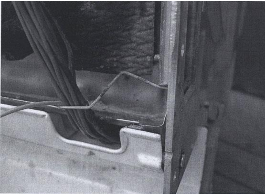
Bild 1. Visar kablageets förläggning i frontluckans nedre del.
