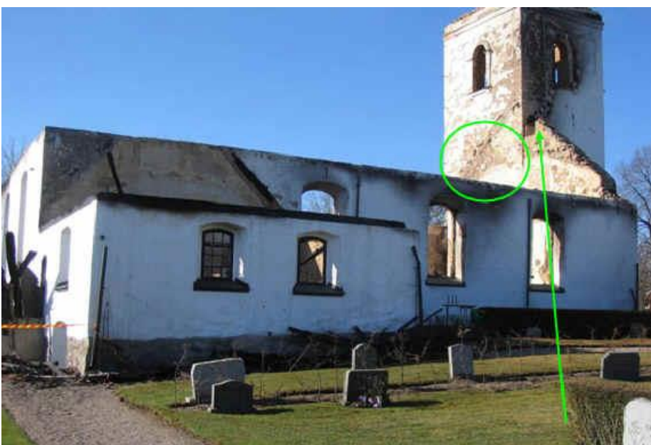
På denna sida av kyrkans tak och torn del startade branden (Pil) Kyrkan är ombyggd i omgångar. Till börja låg tornet centrerat. Markering från gamla taket syns. (Inringat)
