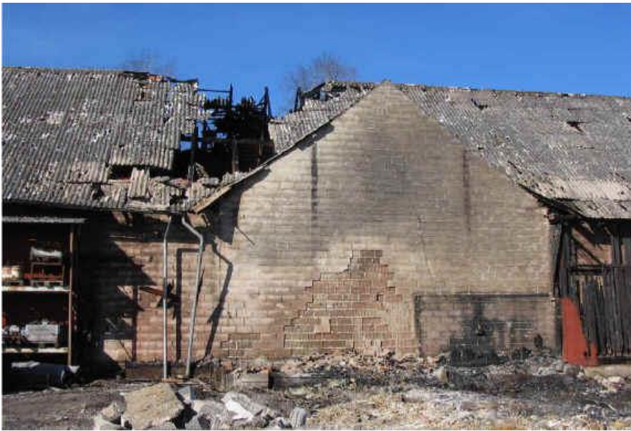
Mellan verkstad och ladugård finns en brandmur. Är en del som förhindrade spridning till ladugård.
