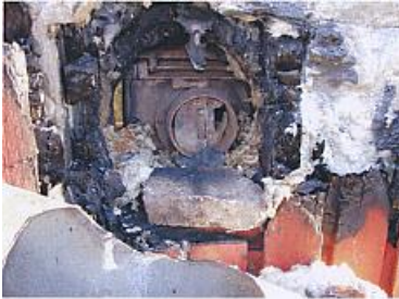
Stödet för rökröret syns när plåten är bortböjd.
