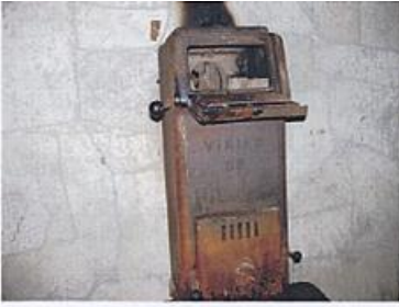
Kaminen stod rakt innanför väggens skyddsplåt
