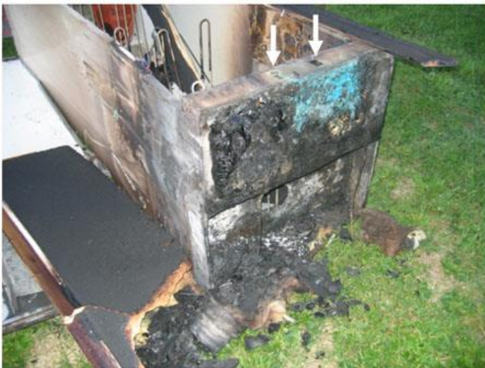
Bild 5: Rester av brännbart material som funnits ovanpå torkskåpet. Pilarna visar var reglagen för torktid och effekt har suttit innan branden.
