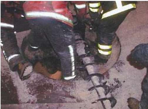
Rotarslussen sedd uppifrån, under själva insatsen. Obs skruven som matar spånet till pannan
