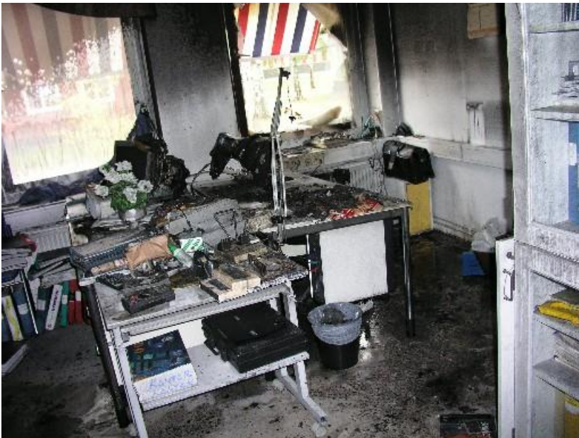
Det brandhärjade kontorsrummet. Fönstret till höger i bild var krossat.
