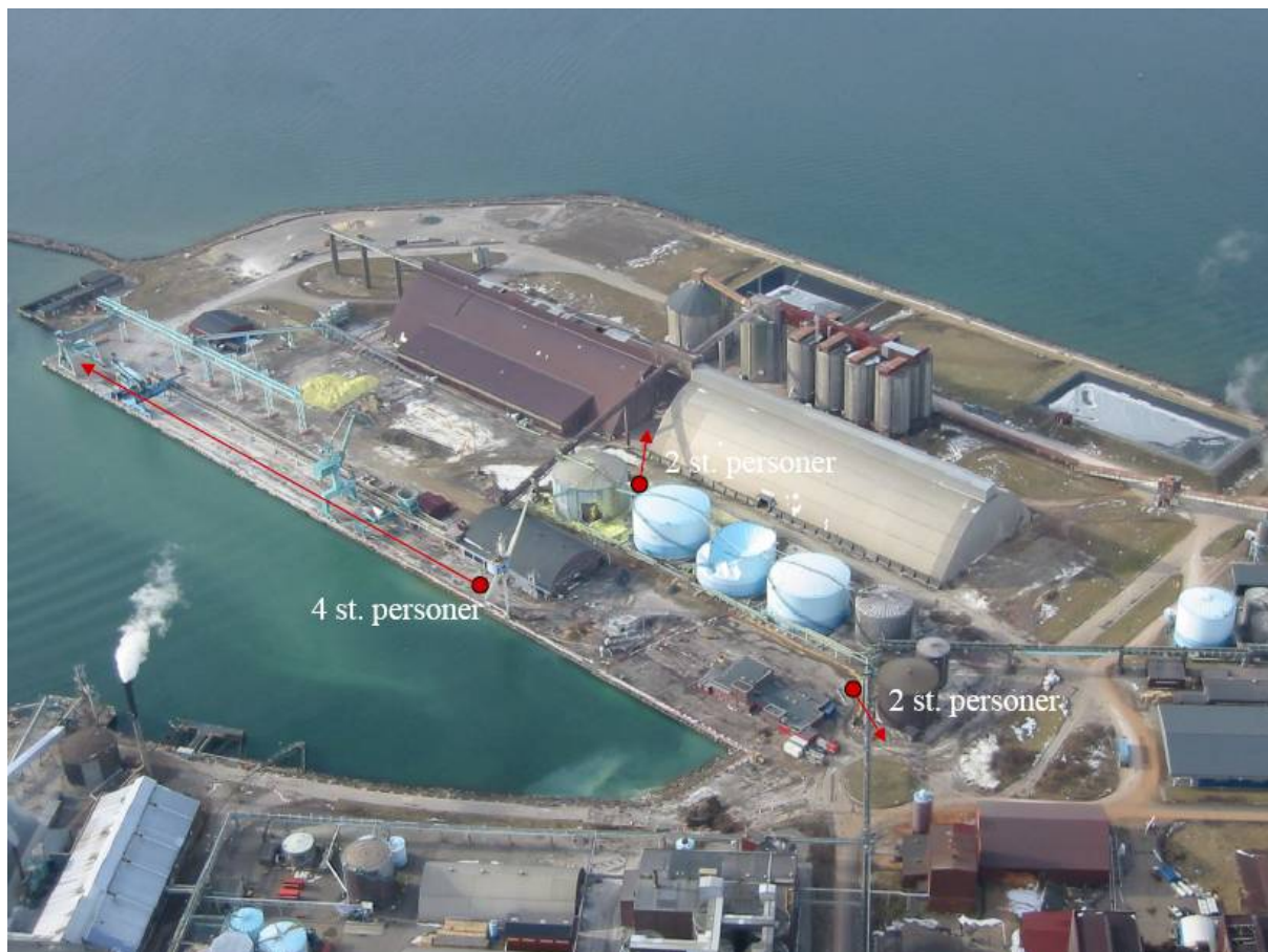
Bild B.5. Vart personerna i fara tog sin tillflykt vid olyckan. De tre vita cisternerna är svavelsyracisterner. Från höger: tom tank, rämnad tank, full tank. Till vänster om de vita cisternerna fanns en tank med flytande svavel. (Kustbevakningen)
