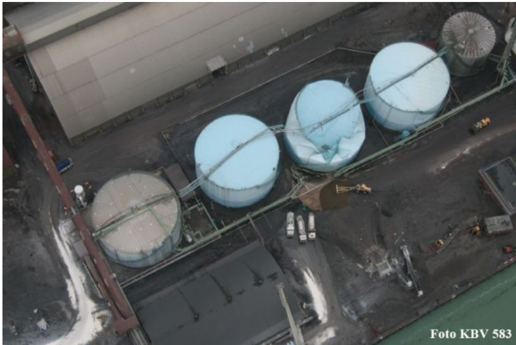
Bild 2. Cisterner från vänster: cistern med flytande svavel, tom svavelsyracistern, rämnad cister samt cistern med 19500 ton svavelsyra. (Kustbevakningen)
