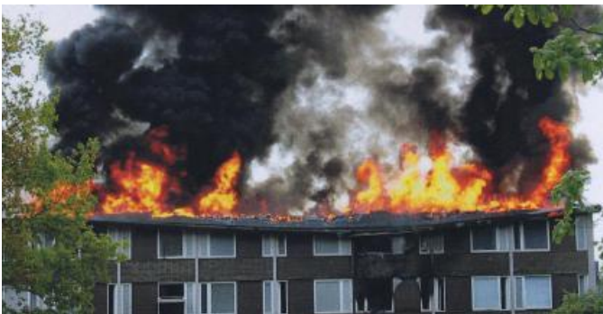
Takbranden. Rökdykarna har släckt av bränderna inne i lägenheterna på våning två och tre. Bilden tagen efter kl 08.08.
