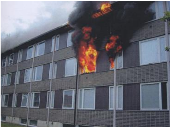
Bilden tagen av insatsledaren vid ankomst till brandplatsen kl 07.25. Man ser hur brandgaserna väller ut från hela byggnadens takfot.
