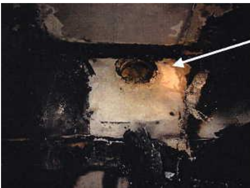
Anslutningen till imkanalen som är ingjuten i väggen.
