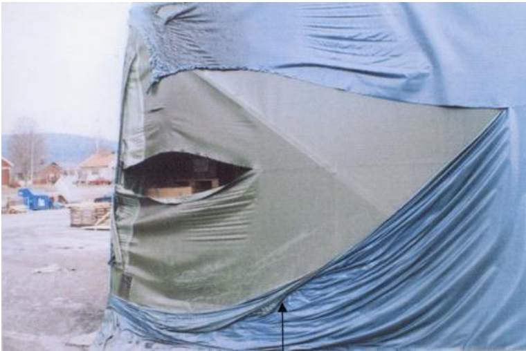
Hörnet på intilliggande tält/förråd. Plasten smälte av värmen.
