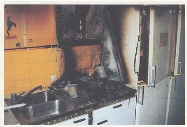
Den inre plattan var påslagen på 6:an. Branden spred sig upp mot taket.
