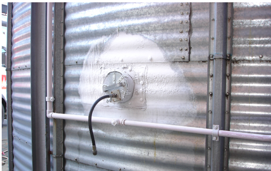
Det bildades is i rörsystemet till det fasta koldioxidssystemet samt inne i träpulvret.
