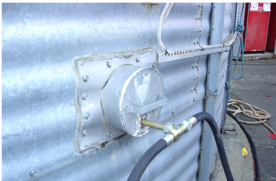
Dysorna till koldioxidssystemet demonterades och lansar för kvävgasinmatning fördes in i träpulvret.
