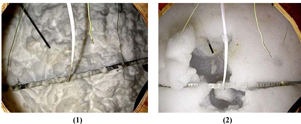
Figur 43 (1) Skumbegjutningen av silotoppen genomfördes med tryckluftsgenererat skum för att minimera dräneringen av vatten. (2) Skummet har en mycket långsam nedbrytning men skumtäckets behöver förnyas när öppningar börjar uppstå.
