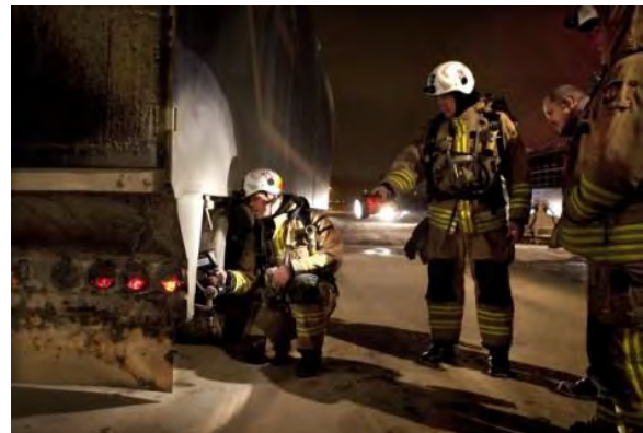
Figur 2 - Värmekontroll. "Fortfarande varmt bland kablarna", konstaterar Torbjörn Svensson som mäter temperaturen med en värmekamera.
