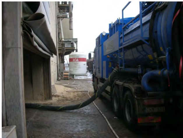
Figur 8 – Tömning med hjälp av sugbil
