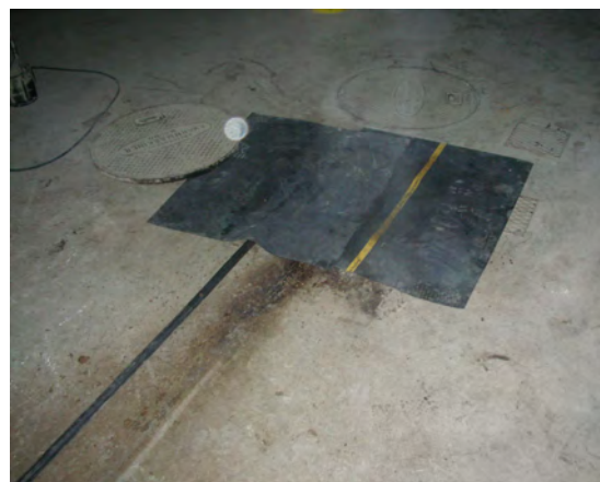
Figur 5 – Toppen av silon täcktes med gummimatta
