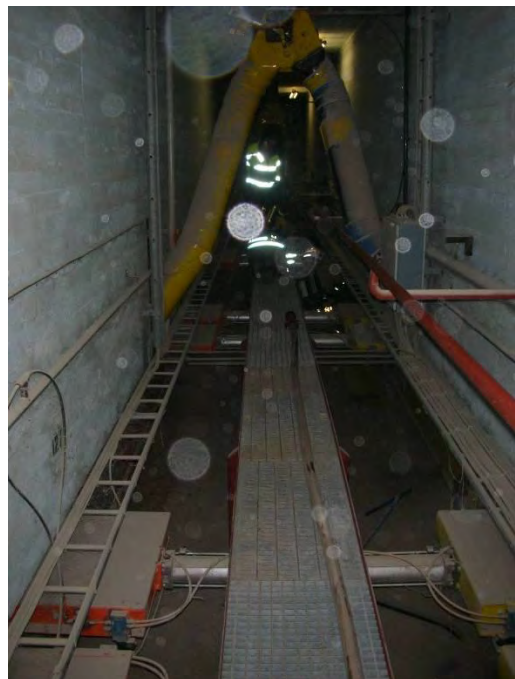
Figur 7 – utrymmet vid botten av silon där materialet togs ut (alternativ 2)
