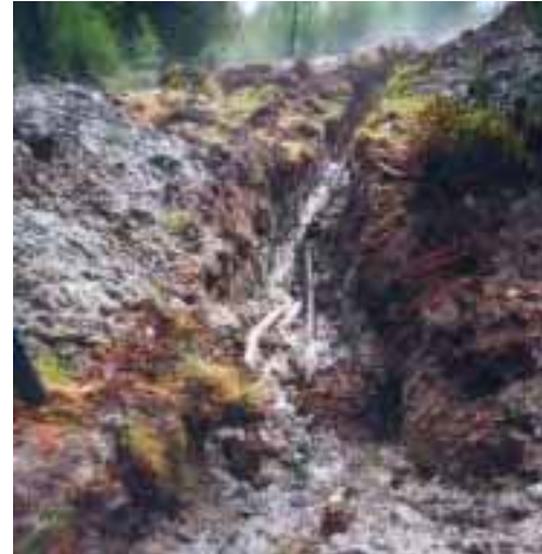
Figur 14 Pågående grävning för dränledningar i en slänt i Ötzdalen, Österrike. Foto: J. Fallsvik, SGI.
