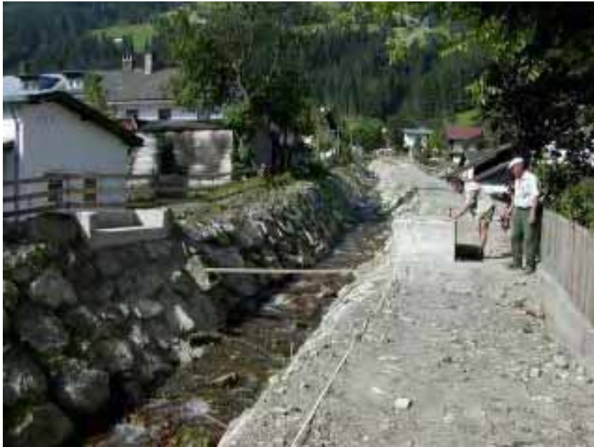
Figur 34. Kanalisering av Kaltenbach, Österrike. Foto: S. Sauermoser, WLW, Schwaz.
