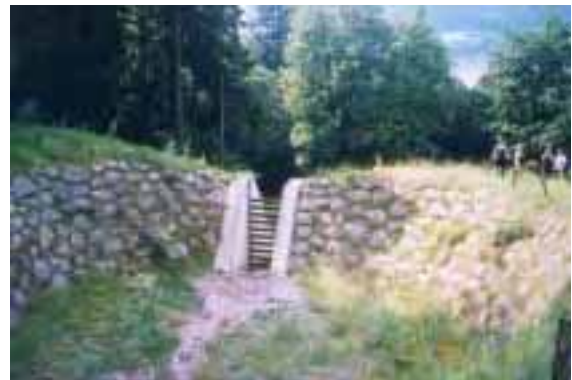
Figur 40 Sedimentationsdamm med stensatta jordvallar. Utflödet med galler av vertikal typ. Rettenbach, Schwaz.. Foto: J. Fallsvik, SGI.
