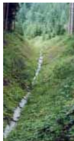
Figur 13 Öppet dike med plåträna. Rettenbach, Österrike. Foto: J. Fallsvik, SGI.
