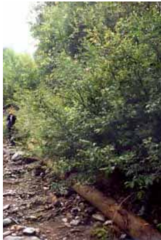
Figur 49. Utbredningslager. Principskiss i plan (vänster) samt ett utbredningslager i Bitzbach, Italien (höger). Foto: K. Rankka, SGI.
