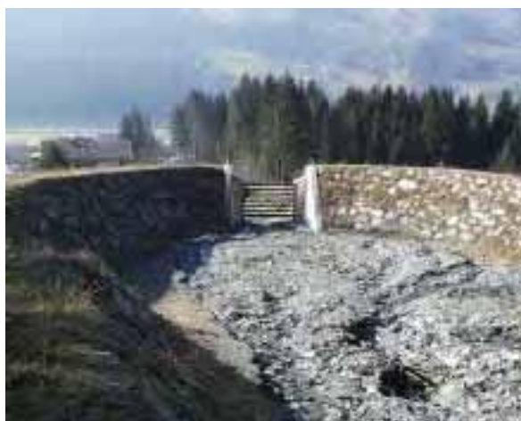
Figur 37 Sedimentationsdamm i Ahrnbach, Österrike. Foto: S. Sauermoser, WLV, Schwaz.
