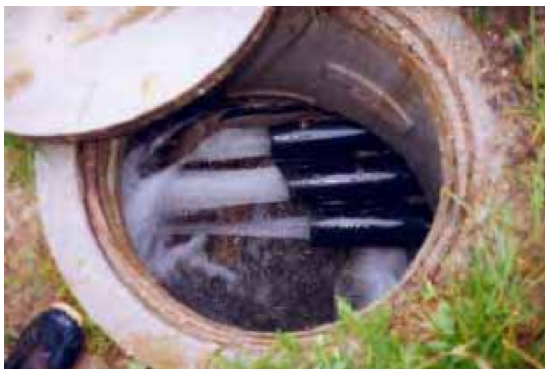
Figur 11 Tryckutjämningsbrunn med tre anslutande dräneringsledningar, Öttdalen, Österrike. Foto: J. Fallsvik, SGI.
