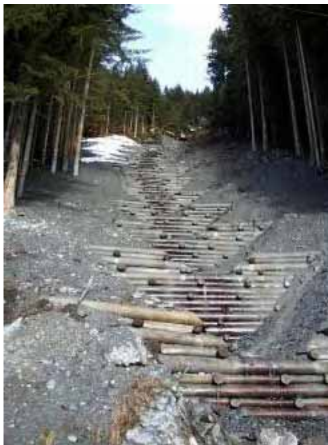
Figur 21. Nybyggda erosionstrappor i trä. Zillerdalen, Österrike. Foto S. Sauermoser, WLV, Schwaz.
