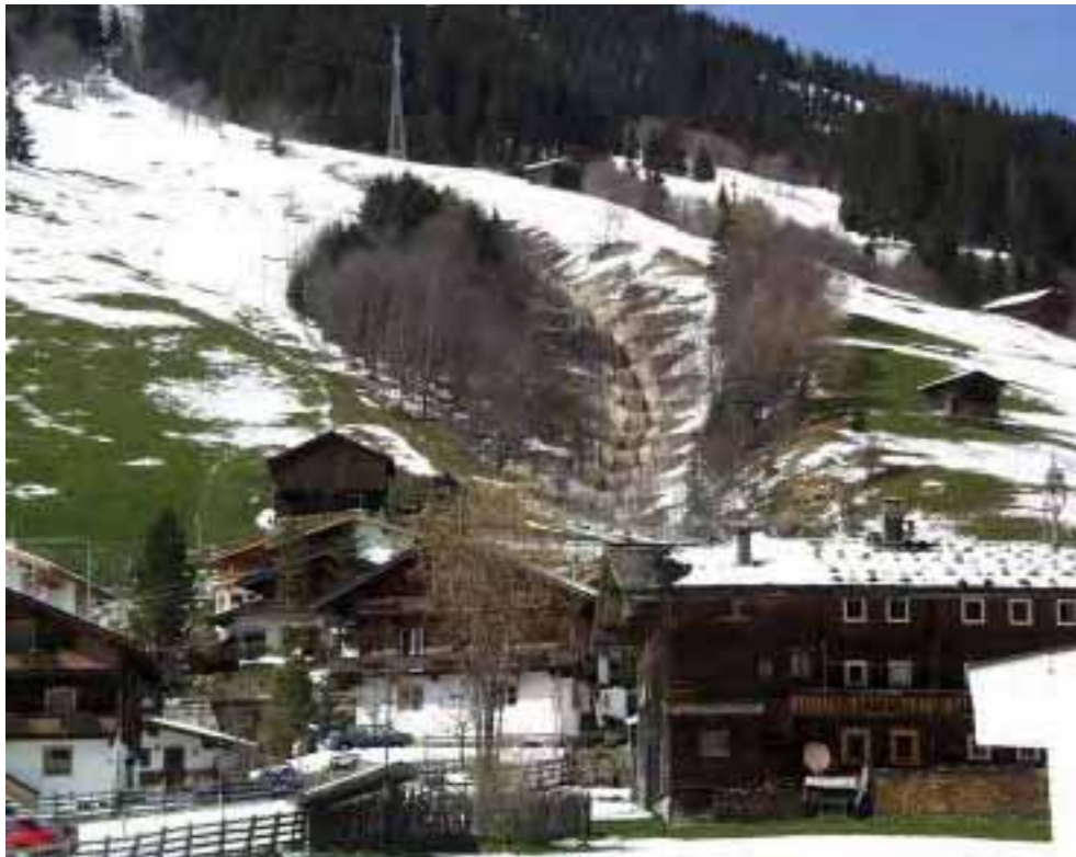
Figur 17 Erosionstrappor i Zillertal, Österrike. Foto S. Sauermoser, WLV, Schwaz.
