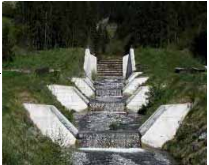
Figur 46. Skydd mot erosion nedströms sedimentationsdamm i form av steninklädning och erosionstrappa. Principskiss till vänster och utförd åtgärd i Ahrnbach, Österrike. Foto: S. Sauermoser, WLV, Schwaz.
