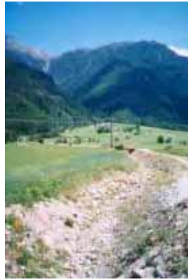
Figur 33 Aluvialkon samt anlagd ny strömfåra med skyddande stensättning, Neudorf, Ötz, Österrike. Foto J. Fallsvik, SGI.
