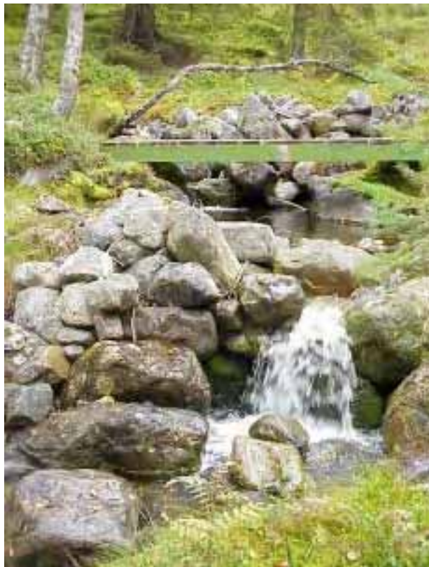
Figur 27. Enkel blocktrappa i Höglekardalen, Jämtland. Foto: K. Rankka, SGI
