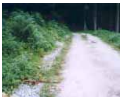
Figur 12 Schakt med dräneringsledning återfylld med dräneringsgrus. Rettenbach, Schwaz, Österrike, Foto: J.Fallsvik, SGI.
