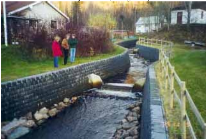
Figur 35. Kanalisering av Kvarnbäcken, Syslebäck. Foto: J. Fallsvik, SGI.
