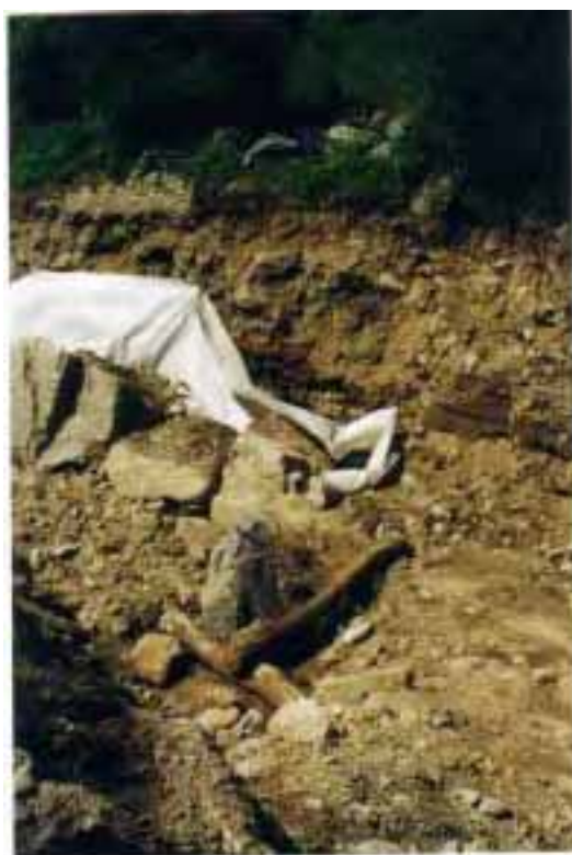
Figur 29. Stabilisering av en ny bäckfåras sidoslänter och botten. Under konstruktion (vänster) och efter färdigställande (höger). Muhlbach, Öttdalen, Österrike. Foto: K. Rankka, SGI.
