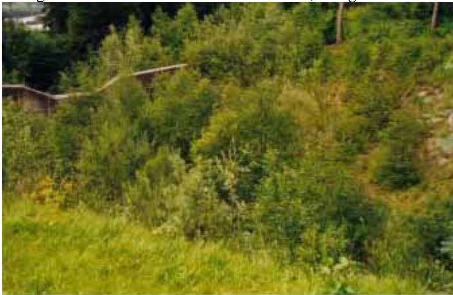
Figur 48. Sedimentationsdamm i Rettenbach, Österrike. Vegetation längs sidoslänter etablerad med sticklingmetoden. Foto: K. Rankka, SGI.
