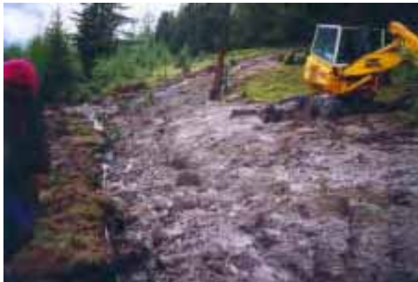
Figur 14 Pågående grävning för dränledningar i en slänt i Ötzdalen, Österrike. Foto: J. Fallsvik, SGI.
