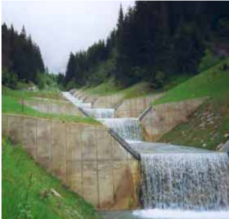
Figur 16 Erosionstrappor i Axamerbach, Österrike. Foto: J. Fallsvik, SGI.
