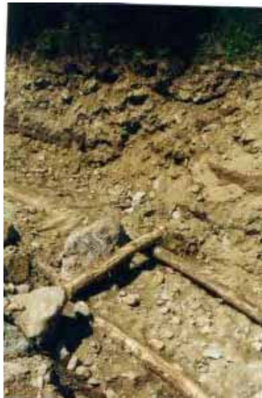
Figur 28. Blocktrappa under konstruktion. Muhlbach, Ötzdalen, Österrike. Foto: K. Rankka, SGI.
