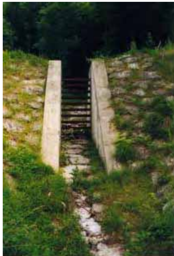
Figur 36. Sedimentationsdamm med gallerförsedd öppning. Rettenbach, Schwaz, Österrike. Foto. K. Rankka, SGI
