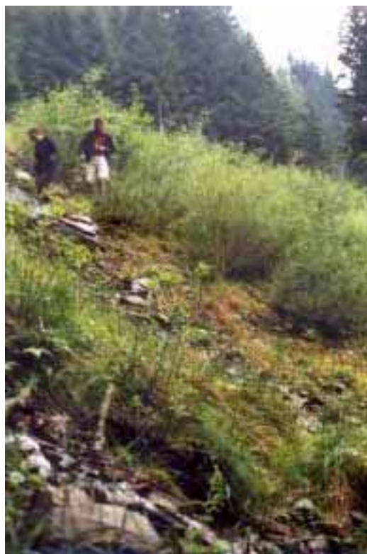
Figur 51. Gren- och häcklagermetoden i Spessbach, Italien. Foto: K. Rankka, SGI.
