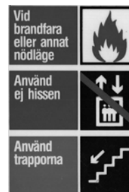
Bild 9.1 Skylt vid hiss som ej ska användas vid utrymning
