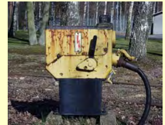
Tågvärmepost, äldre
